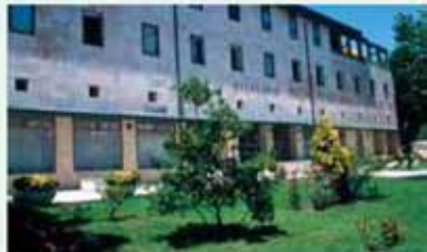
Panorámica del nuevo Balneario
